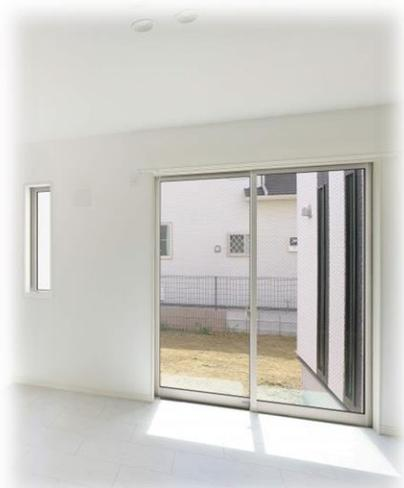
枠・障子がアルミで、複層ガラスにより断熱性をアップ。ガラス面の結露対策に加えて、樹脂アングルの採用により、窓まわりの結露の発生を抑えます。
